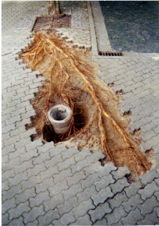
Abb. 3: Platanus acerifolia – In der Pflasterbettung hat sich ein ausgedehntes Wurzelsystem bis über die Kronentraufe hinaus entwickelt. An einem Ablauf streichen die Wurzeln in tiefere Bodenschichten.
